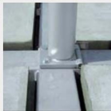
Ausgestattet mit einem Kippscharnieranschluss können Masttypen der Z90-Serie mit und ohne Drehausleger in den Nennhöhen 6 und 7 m von nur einer Person ohne Hilfsmittel sicher und schnell aufgestellt werden.
