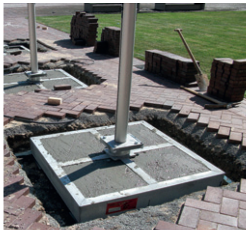
Stahlrahmen zur Fundamentverbreiterung für „schwimmenden“ Einbau auf Tiefgaragen.
