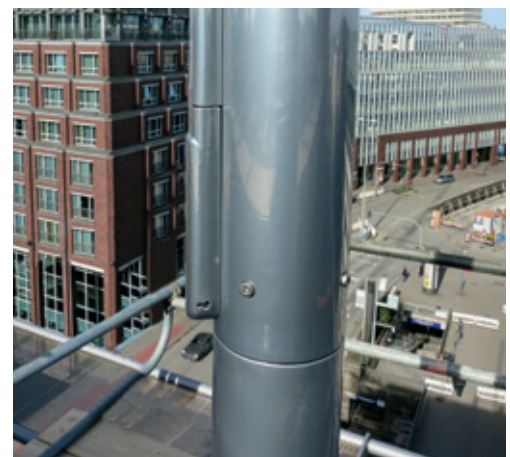
Mastrohr 2-teilig mit Drehlagerung, Fassadenmontage
