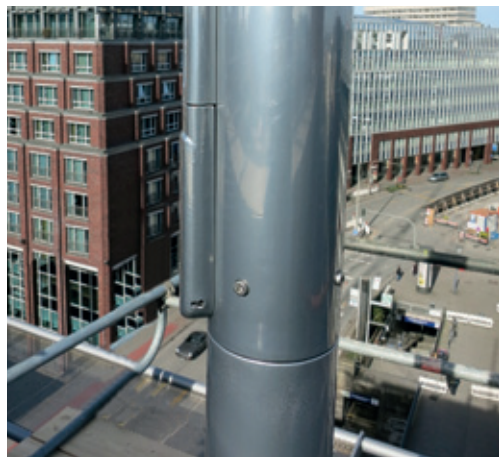
Mastrohr 2-teilig mit Drehlagerung, Fassadenmontage
